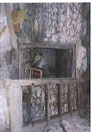
Konstruksioni i mureve në përdhese
