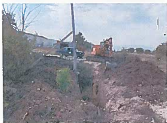
Intervenimet emergjente në rrjetin e kanalizimit. Projekt i përfunduar.
