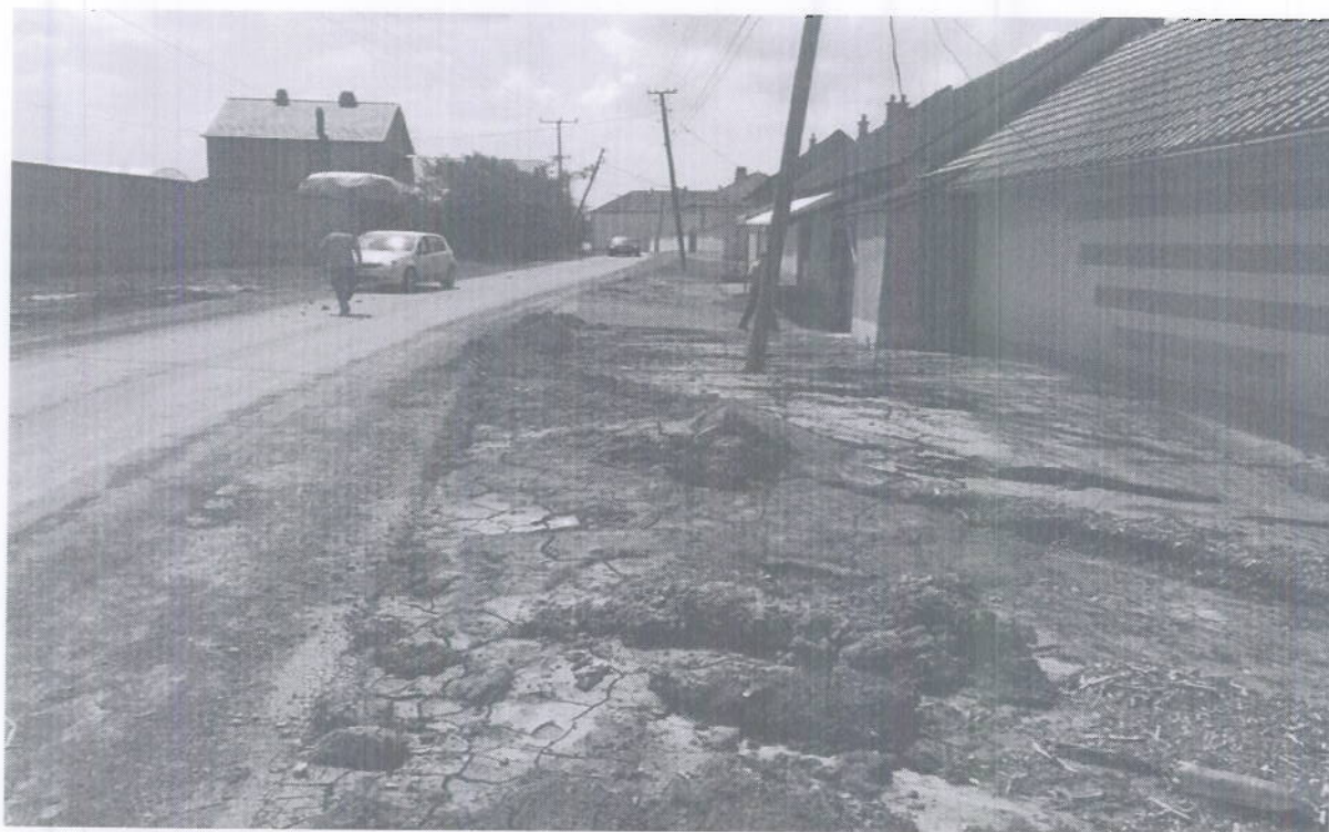
Mbushja e trotuarëve dhe rrugës me baltë.
